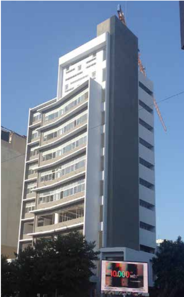
EDIFÍCIO AUTORIDADE TRIBUTÁRIA
