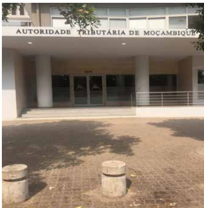
EDIFÍCIO AUTORIDADE TRIBUTÁRIA
